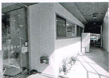
事務所拡張部分
